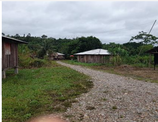
Institución Educativa primaria en mantenimiento,
