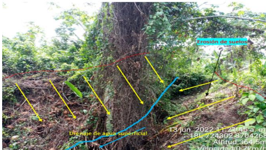
FIGURA 210: VISTA DE AFLORAMIENTO DE EROSIÓN DE SUELOS EN EL SECTOR BARRIO TERMINAL, CORRESPONDIENTE A LA ZONA DE INTERVENCIÓN DIRECTA.
