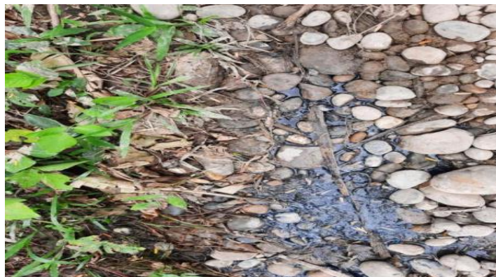
FIGURA 21: AGUAS SERVIDAS VERTIDAS A LAS CALLES
