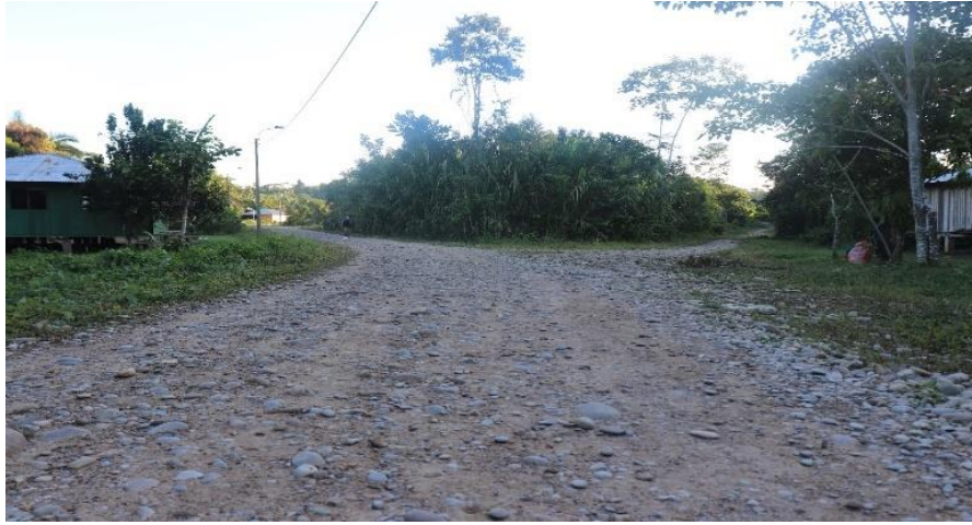
FIGURA 117: VÍA URBANA DE LA COMUNIDAD NATIVA DE SHIVANKORENI.
