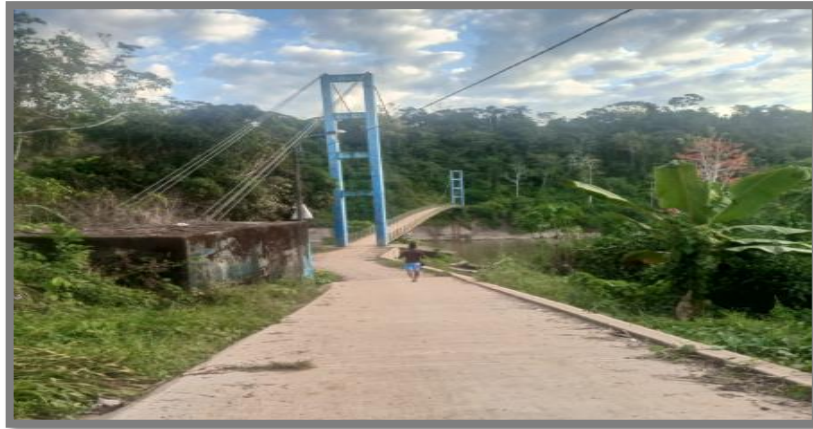
FIGURA 172: ZONA PEATONAL CONTINUA AL PUENTE
