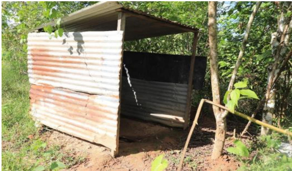
FIGURA 146: MODULO DE SERVICIOS HIGIÉNICOS EN LA LOCALIDAD
