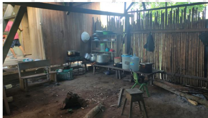
FIGURA 37: VIVIENDA DE UNA PLANTA EN CONSTRUCCIÓN, VIVIENDA DE UNA PLANTA CON ÁREA COMÚN.
