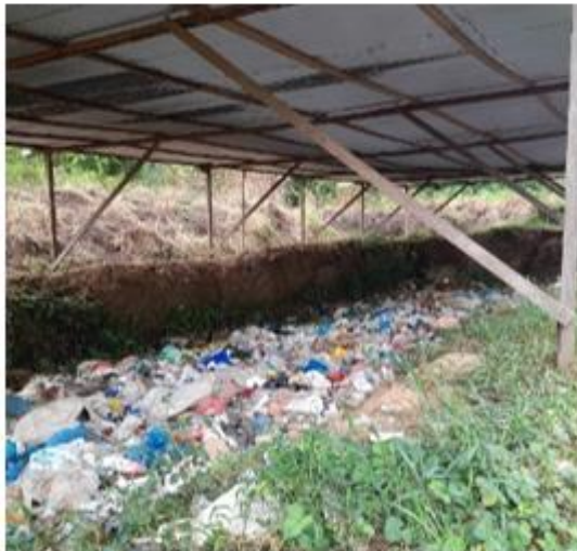
No presenta ninguna estructura para el manejo de residuos sólidos inorgánicos.
