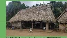
INACEN C3. Es un tipo de vivienda de tipo TRADICIONAL en el que se utilizan materiales locales como el adobe, el barro y el paja para la construcción de las paredes y techos. Las viviendas son de una o dos plantas y tienen un diseño simple y funcional.
