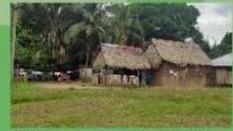
IMAGEN 22. Es un tipo de vivienda de tipo RUSTICO, que se caracterizó por el uso de materiales locales en la construcción de las paredes y techos de palma o caña, con un sistema de ventilación natural y cubierta de palma y caña.
