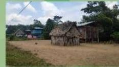
IMAGEN 21. Es un tipo de vivienda de tipo AUTÓCTONO el cual se caracterizó por el uso de materiales locales en la construcción de las paredes y techos de palma o caña, con un sistema de ventilación natural y cubierta de palma y caña.
