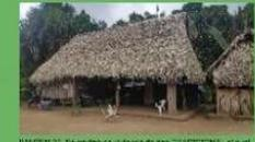
IMAGEN 23. Es un tipo de vivienda de tipo TRADICIONAL, el cual se caracterizó por el uso de materiales locales en la construcción de las paredes y techos de palma o caña, con un sistema de ventilación natural y cubierta de palma y caña.
