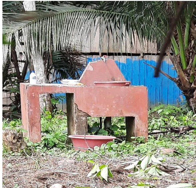
Fotografía N° 2. Piletta de agua fuera de la vivienda
