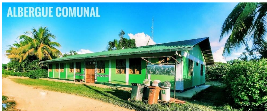
Imagen 38 Vista Del Albergue Comunal
