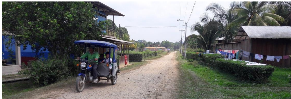
Figura N° 41: TRAMO DE VIA PRINCIPAL CON SUPERFICIE AFIRMADA
