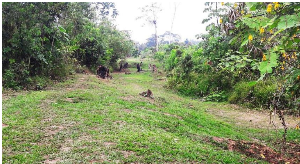
Figura N° 62: VIA CON MALA ARTICULACION EN EL BARRIO MIRAFLORES
