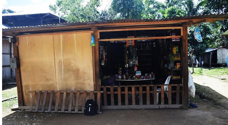
Figura N° 12: FACHADA DE VIVIENDA – COMERCIO (TIENDA DE ABARROTES)
