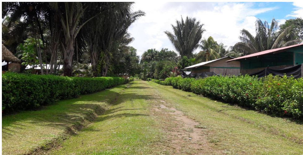
Figura N° 58: CUNETAS TIPO V EN EL BARRIO DE MIRAFLORES
